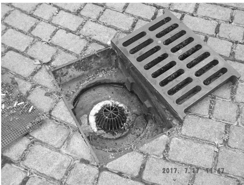
Rys.20. Odkrywka K-4 – widok wpustu ściekowego z wykonanym kołnierzem.
