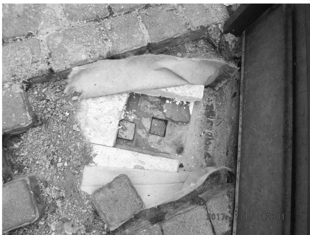
Rys.16. Odkrywka O-3 – widok zawilgoceń górnej warstwy wylewki pod izolacją przeciwwodną.
