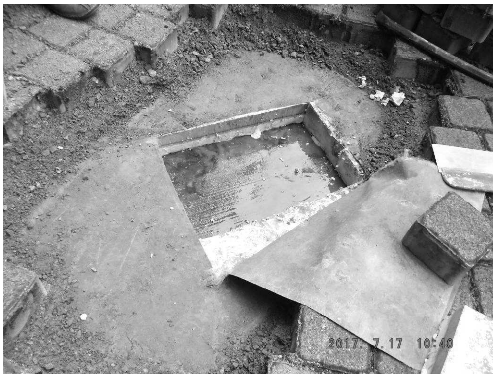
Rys.11. Odkrywka O-1 – widok niewielkich zastoisk wodnych na górnej warstwie papy.
