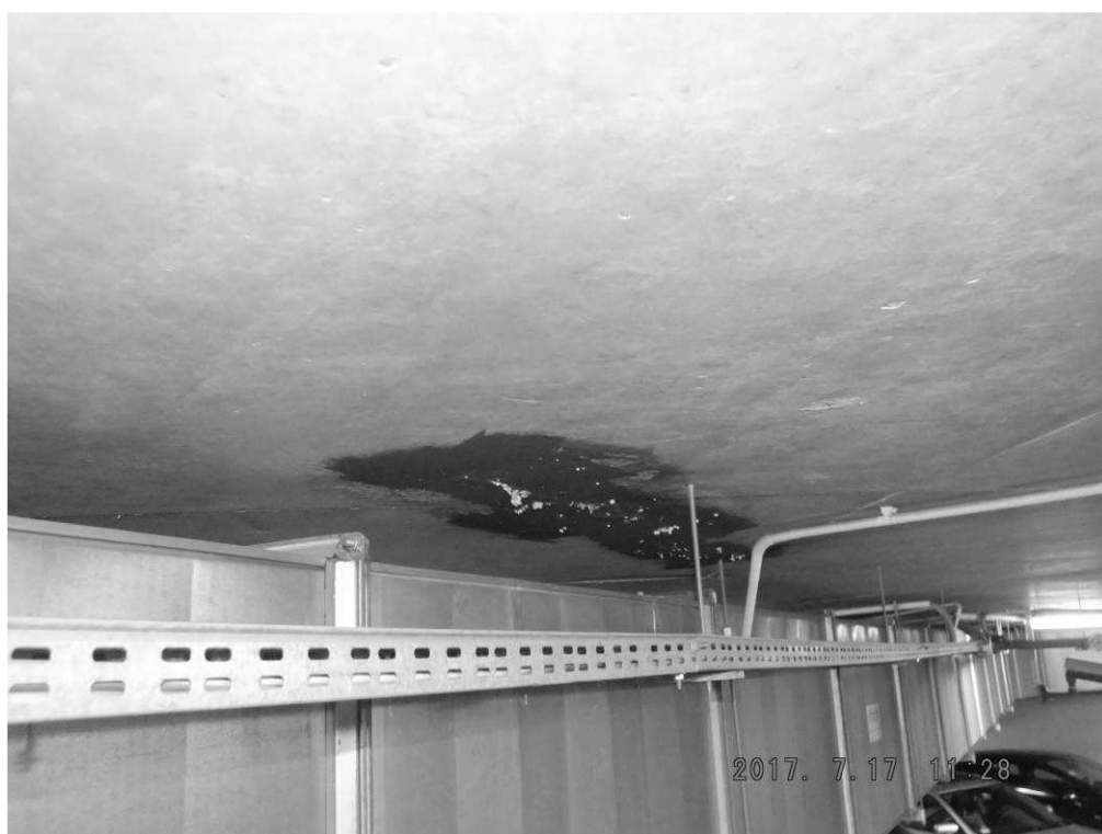
Rys.5. Strop w piwnicy. Widoczne zawilgocenia.
