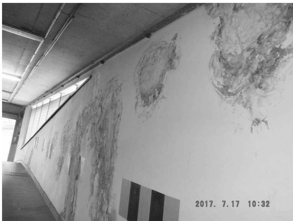
Rys.6. Zawilgocenie i korozja wierzchniej warstwy ściany rampy zjazdowej do garażu podziemnego
