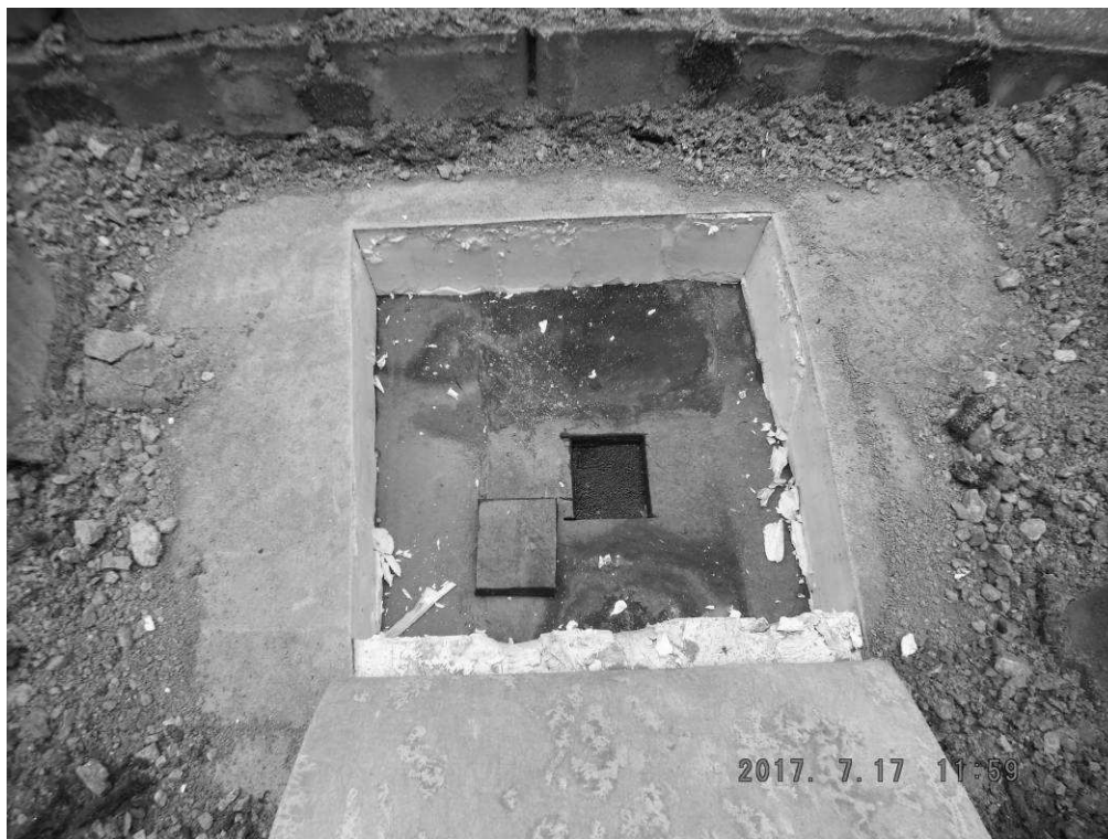
Rys.15. Odkrywka O-2 – widok zawilgoceń górnej warstwy wylewki pod izolacją przeciwwodną.
