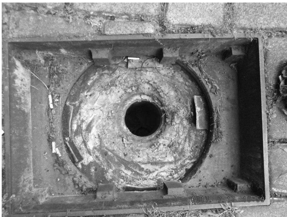
Rys.17. Odkrywka K-1 – widok wpustu ściekowego bez wykonanego prawidłowo kołnierza.
