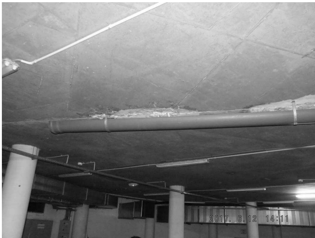
Rys.4. Widok tymczasowego zabezpieczenia w postaci rynien przed wodą opadową i białymi naciekami
