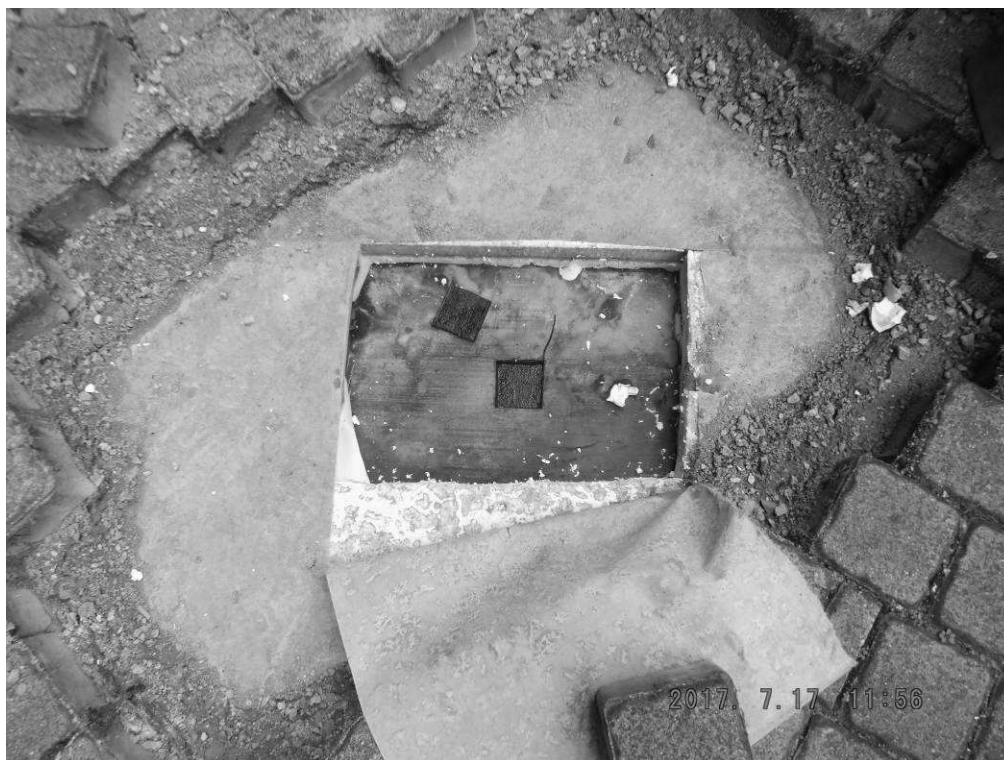
Rys.14. Odkrywka O-1 – widok zawilgoceń górnej warstwy wylewki pod izolacją przeciwwodną.
