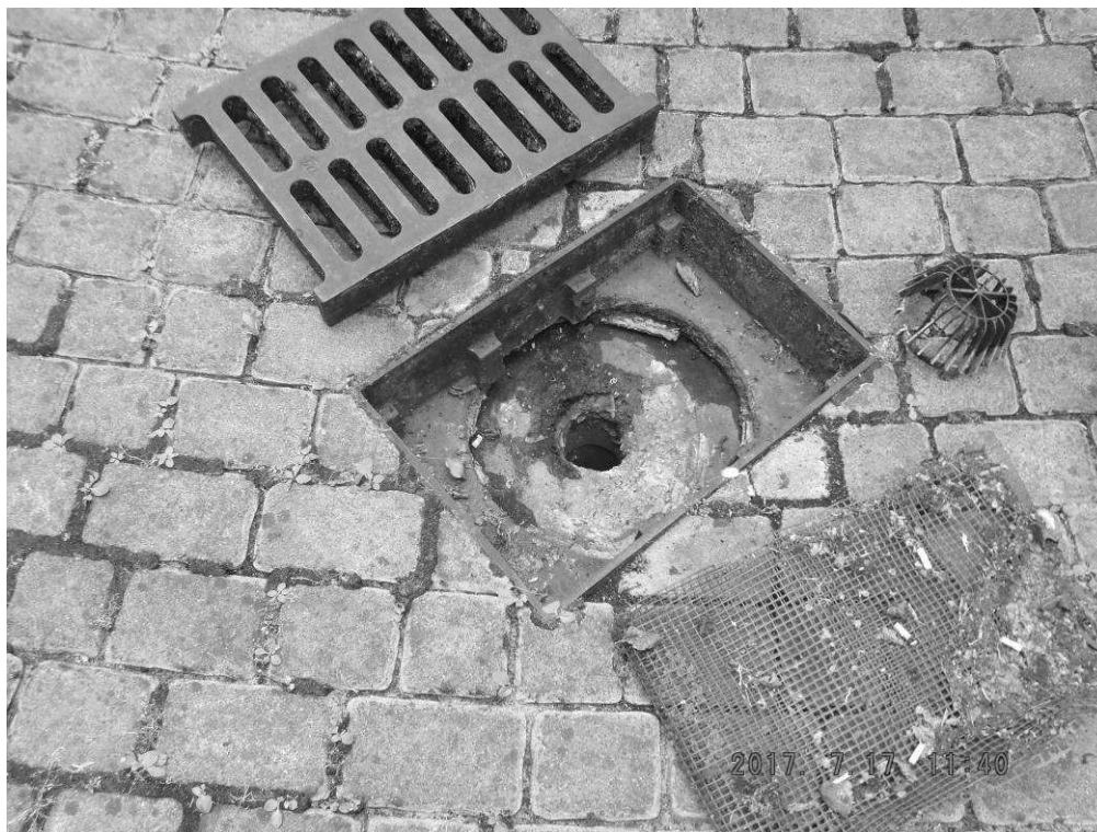
Rys.18. Odkrywka K-3 – widok wpustu ściekowego bez wykonanego prawidłowo kołnierza.
