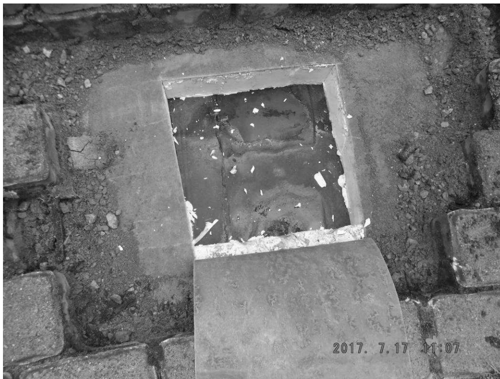
Rys.12. Odkrywka O-2 – widok zawilgoceń pomiędzy warstwą styropianu i papą.
