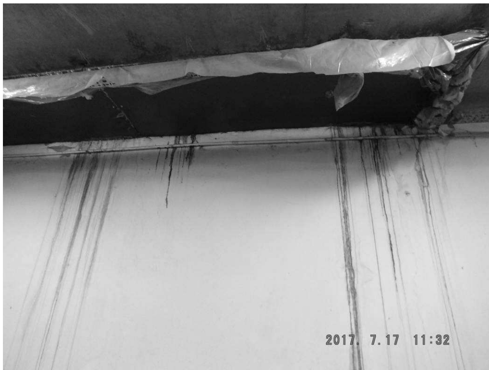
Rys.7. Ściana graniczna w miejscu lokalizacji przebić w stropie. Widoczne pionowe zacieki.
