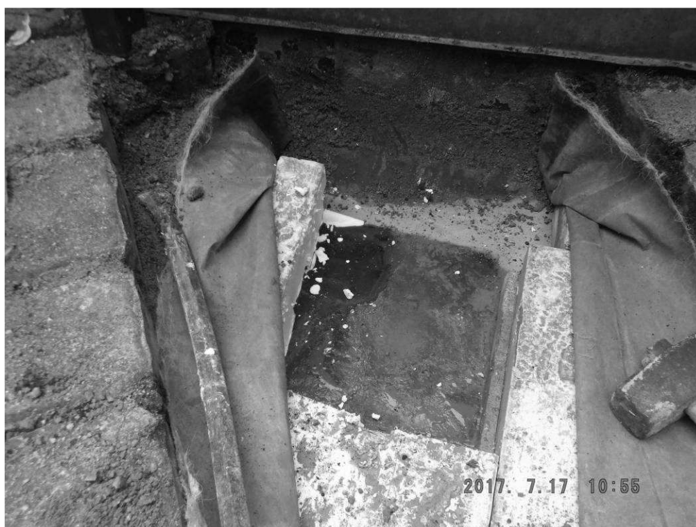
Rys.13. Odkrywka O-3 – widok zawilgoceń pomiędzy warstwą styropianu i papą.
