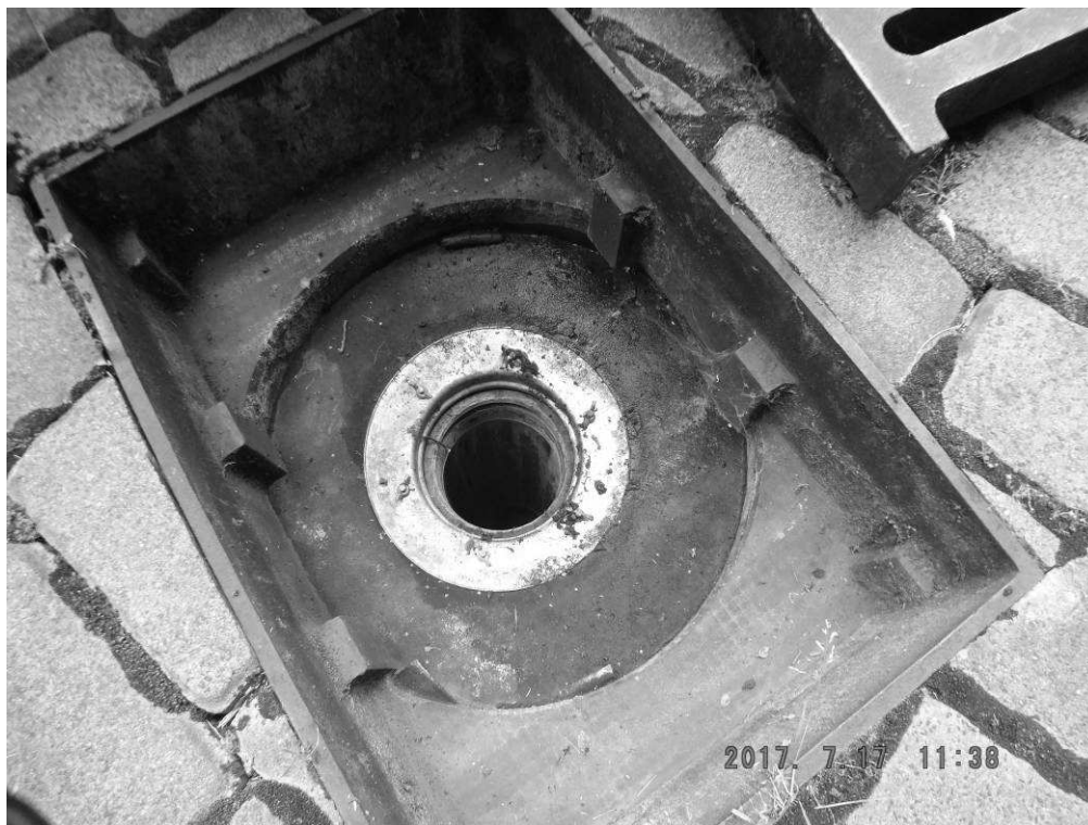
Rys.19. Odkrywka K-2 – widok wpustu ściekowego z wykonanym kołnierzem.
