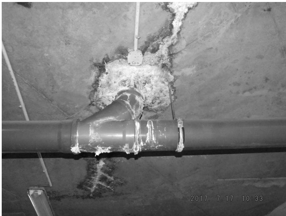
Rys.3. Miejsce przejścia przez strop rury odwadniającej dziedziniec. Widoczne strefy zawilgocenia i białe nacieki.
