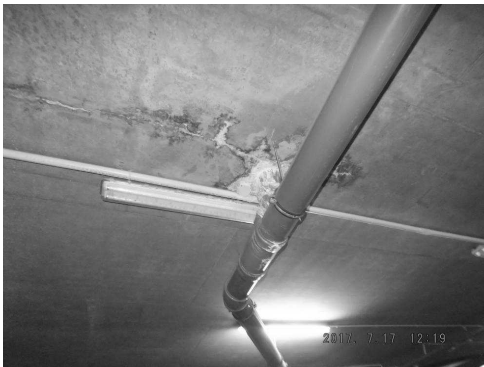
Rys.8. Widoczne rysy stropu pokrywające się z naciekami.
